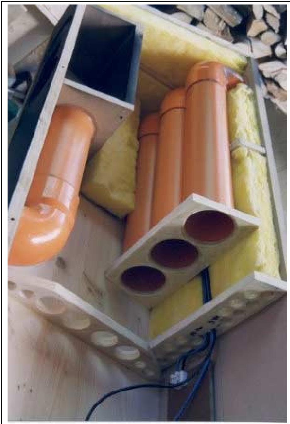
Ecco una ghiotta vista delle nervature dove si evidenzia la particolare foratura, utile a renderle "invisibili" da parte delle onde sonore che viaggiano all'interno del mobile
